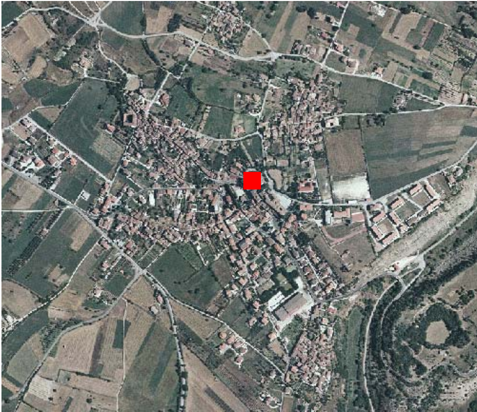
Foto aerea con localizzazione sito stazione
