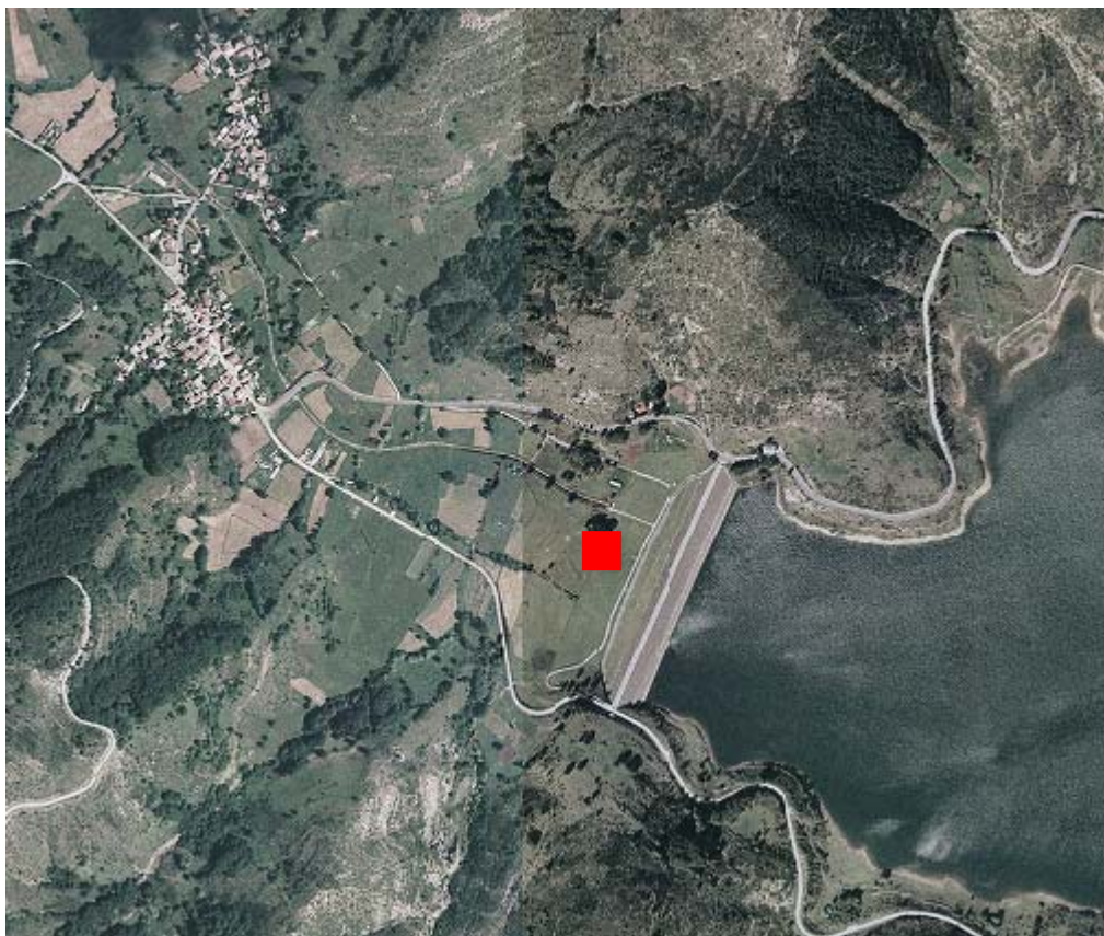
Foto aerea con localizzazione sito stazione
