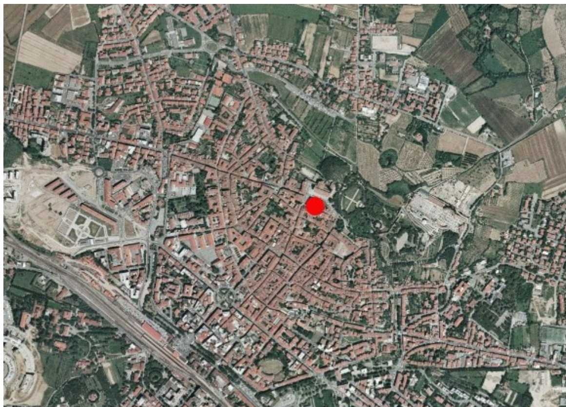
Foto aerea con localizzazione sito stazione
