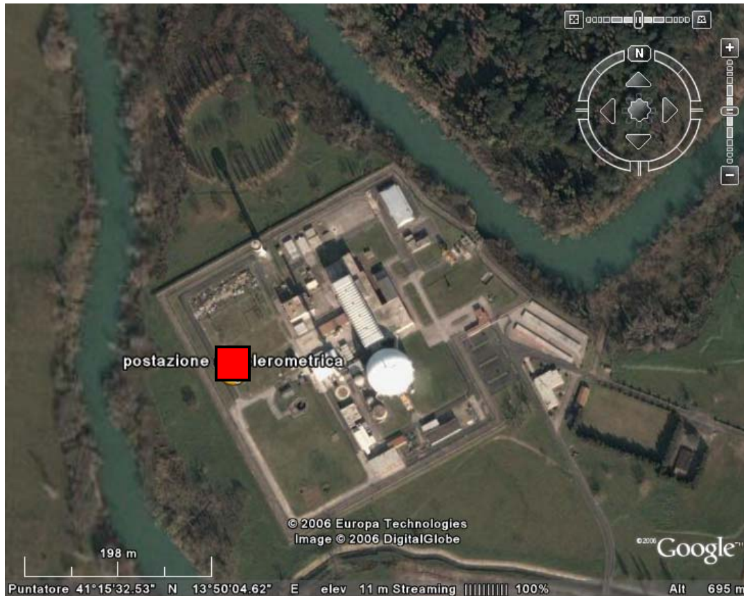
Foto aerea con localizzazione sito stazione
