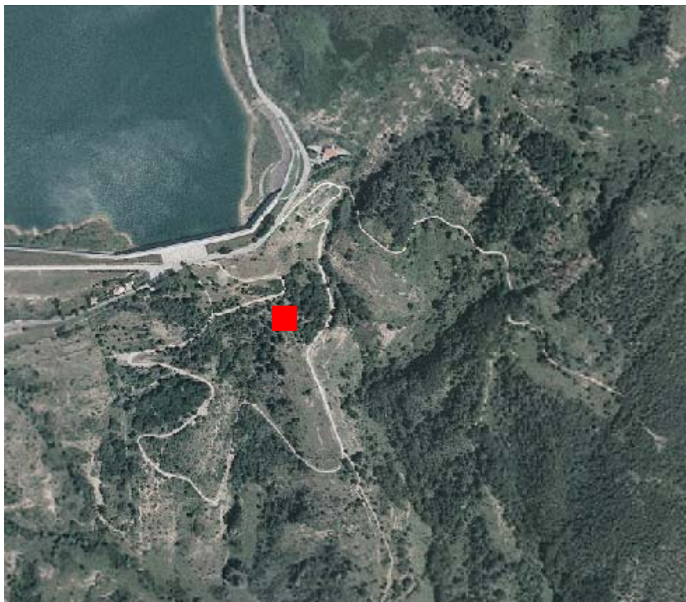
Foto aerea con localizzazione sito stazione
