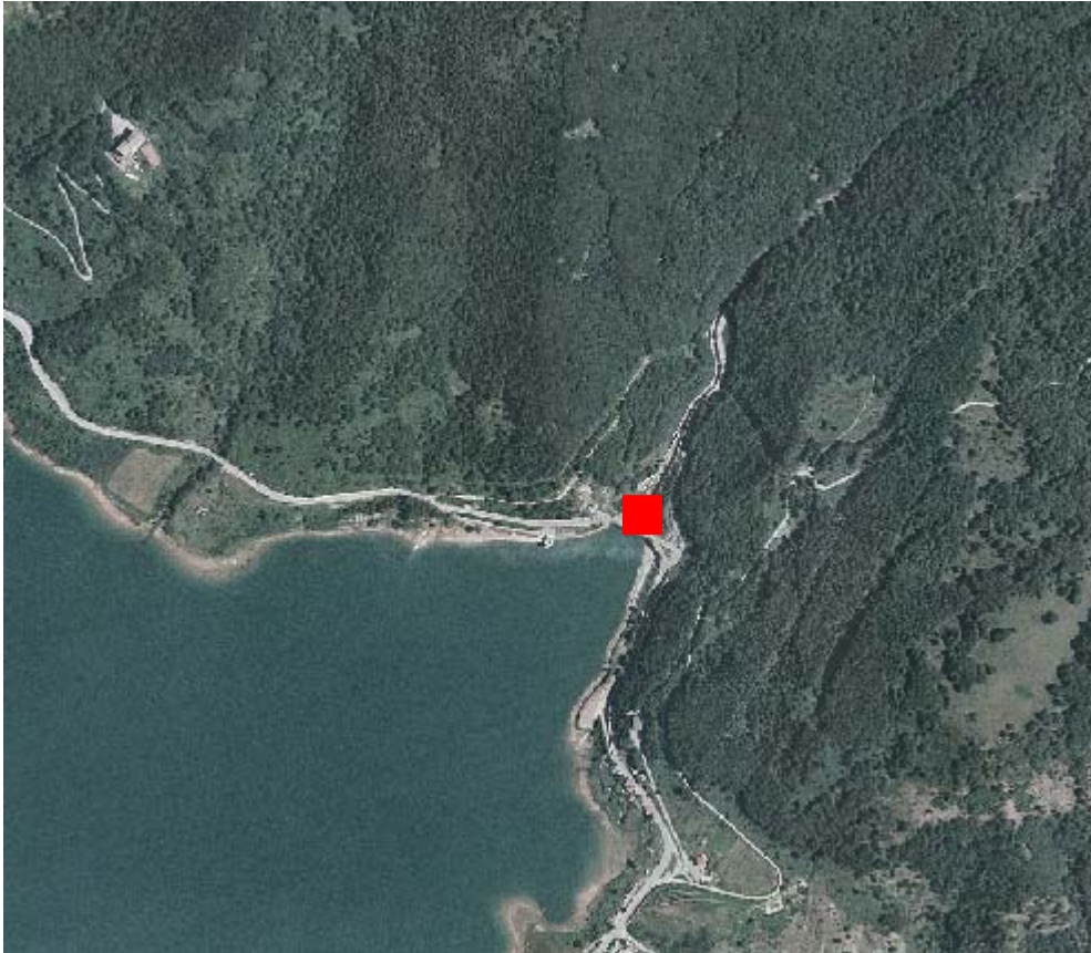
Foto aerea con localizzazione sito stazione
