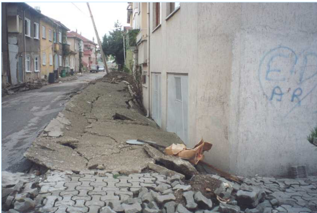
Figura 1.1-3 – Effetti dovuti a liquefazione (Izmit, Turchia, 1999).
