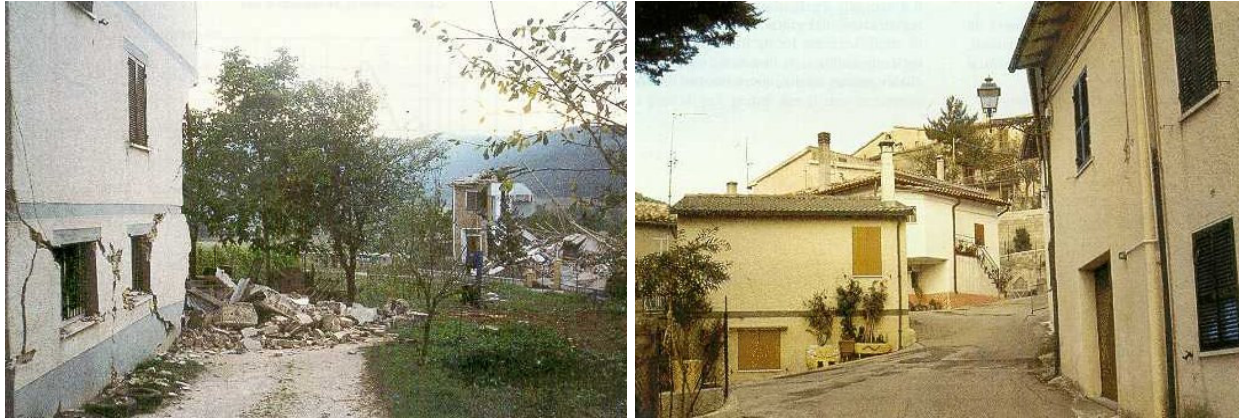
Figura 1.1-2 – Terremoto Umbria Marche, 1997. Differenza di danneggiamento in località vicine, dovute ad effetti locali. A sinistra Cesi Bassa (IX MCS), a destra Cesi Villa (VII MCS)
