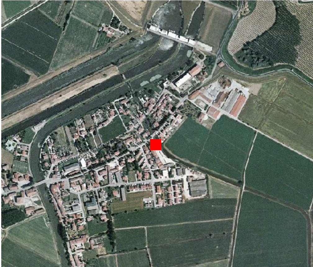
Foto aerea con localizzazione sito stazione
